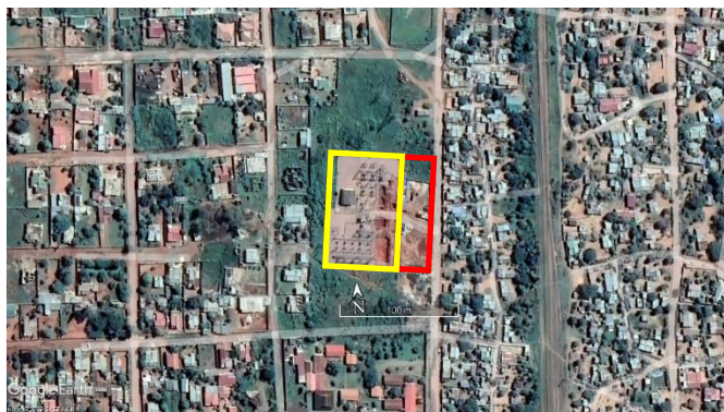
Figure 4 – Subestação de Boane existente (amarelo) área de extensão proposta (vermelho)
